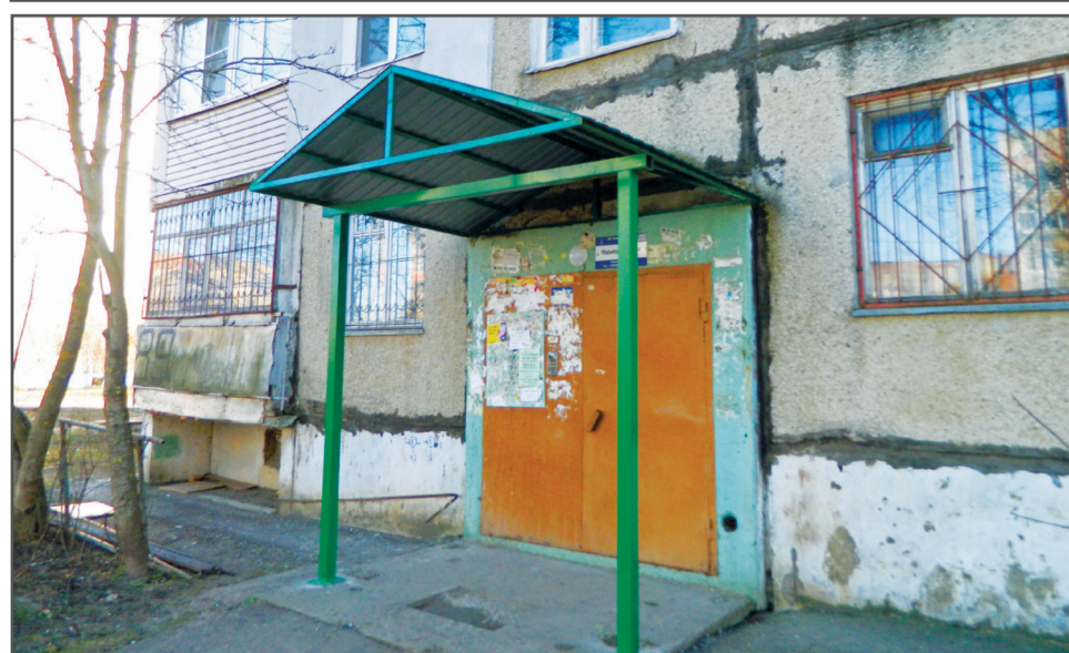
Монтаж новых подъездных козырьков ул. Комсомольская, д. 89
