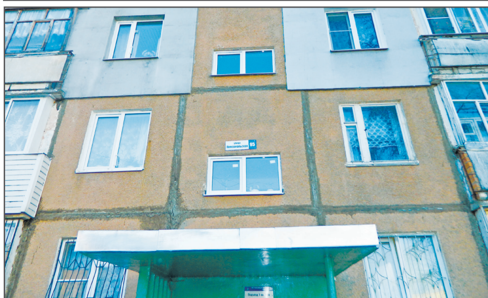
Пластиковые окна в подъездах ул. Комсомольская, д. 95
