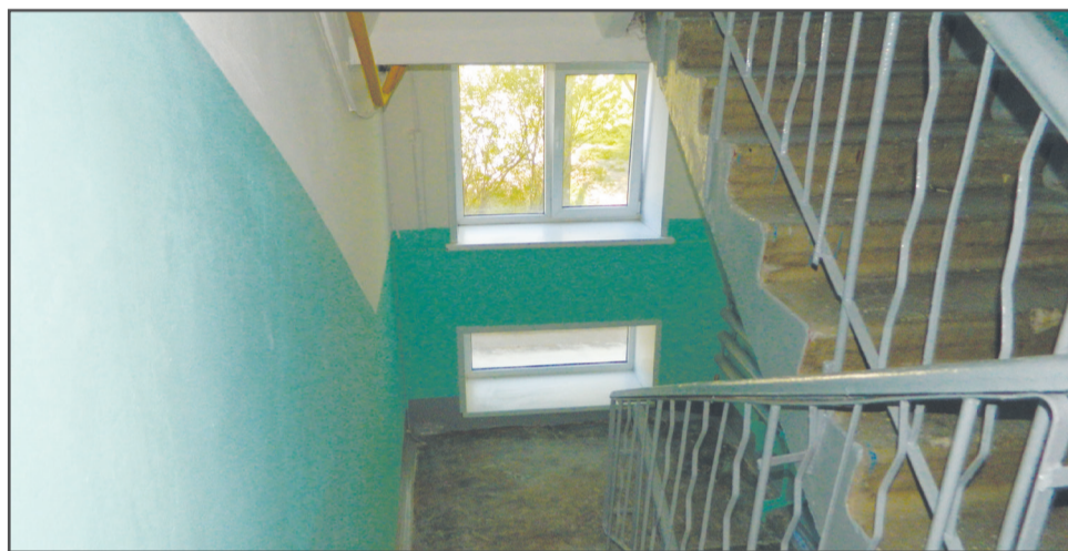
ул. Комсомольская, д.12 Проведен косметический ремонт всех подъездов.
