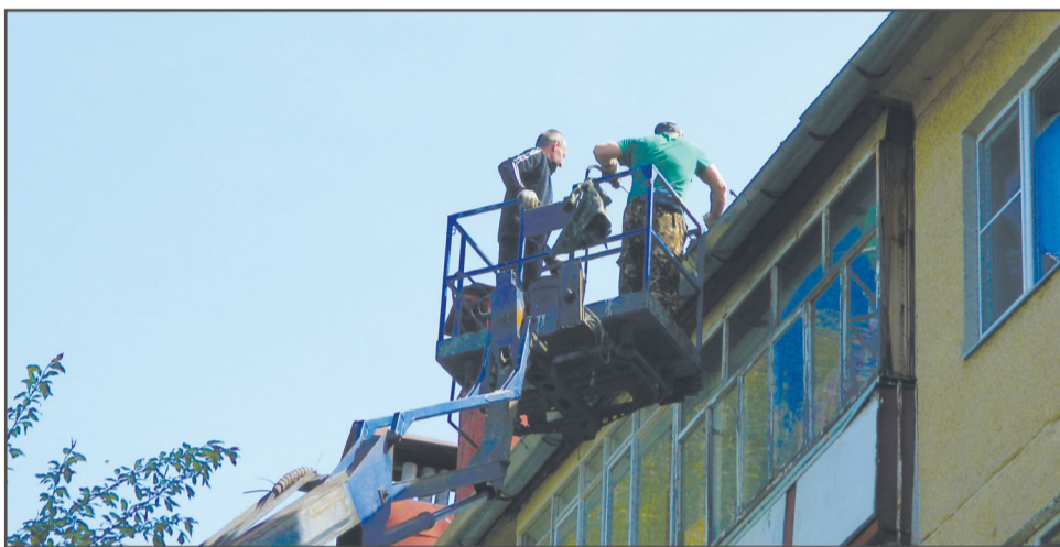
ул. Моторостроителей, д. 58 Очистили и поправили желоба и водосточные трубы, произведен ремонт примыканий.
