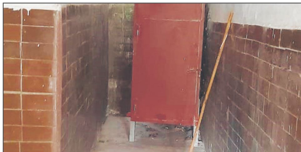
пр-т 50-летия Победы, д. 6. Ремонт мусорокамер и установка металлических, закрытых мусороприемников.
