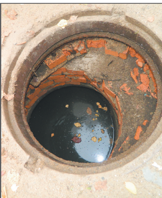
Ливневой и канализационный колодцы рядом с домом забиты. Пока ООО «Тутаевский Водоканал» их не прочистит, вода из подвала дома не уйдет.
